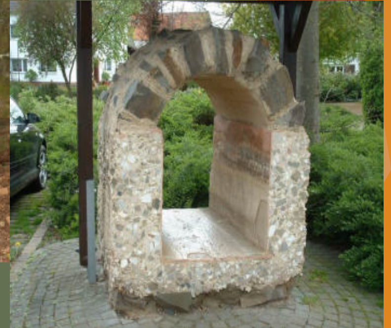
Eifelwasserleitung, Buschhove Bonn/ Deutschland
